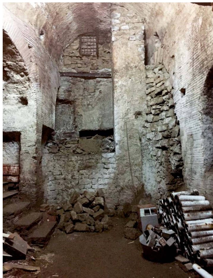
1. Arcate e pilastri dell'acquedotto romano del Serino.
