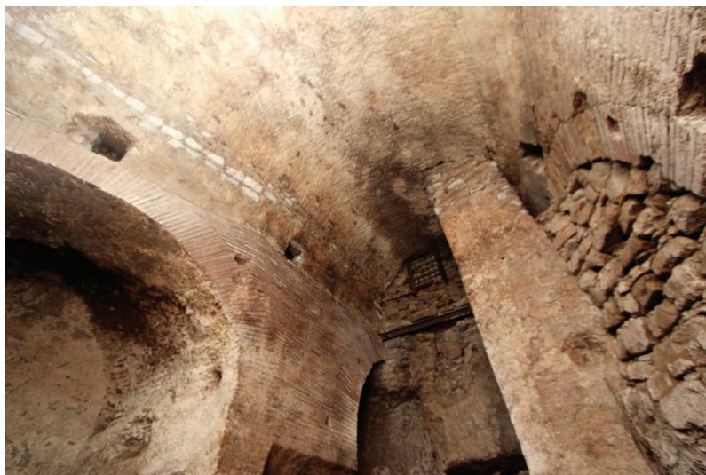
Fig. 3 – Secondo ponte canale: particolare della ghiera dell'arco a pianta trapezoidale
