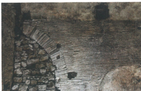
Fig. 7 - Pilastro e arcata murata del ponte-canale ovest.
