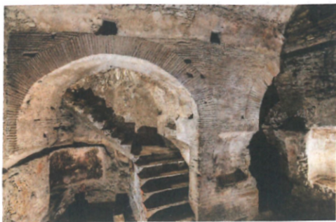
Fig. 4 - Arcata del ponte-canale est.
