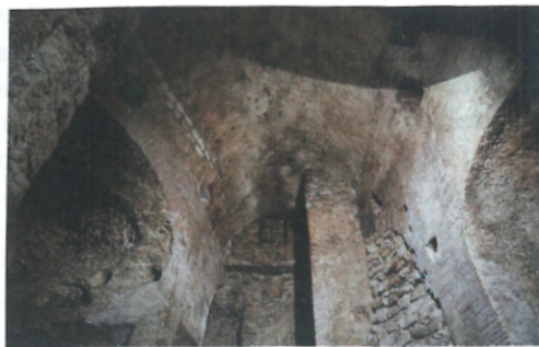
Fig. 5 - Arcate dei ponti-canale e volta a botte appoggiata sulle strutture di epoca romana.
