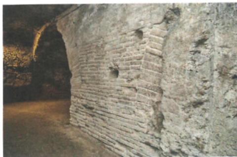
Fig. 6 - Arcate del ponte-canale ovest, dal lato del percorso di accesso allo spazio interrato.
